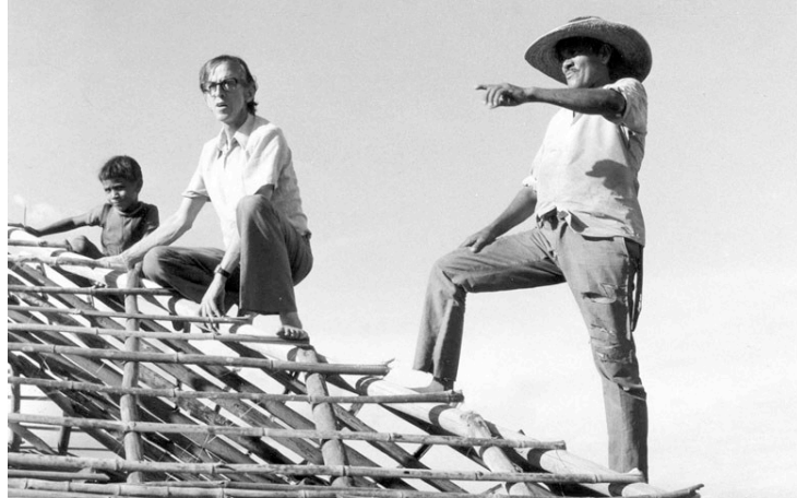
Figura 2: Bispo Pedro ajudando na construção do prédio do GEA.
