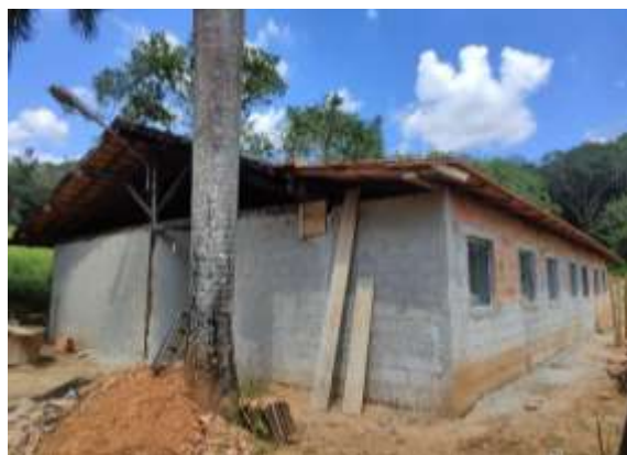
Figura 6. Construção da nova escola. Novo território. Fonte: arquivo pessoal.
