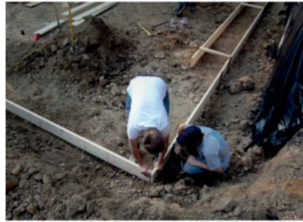
Trabalhadores na etapa de locação do edifício.
