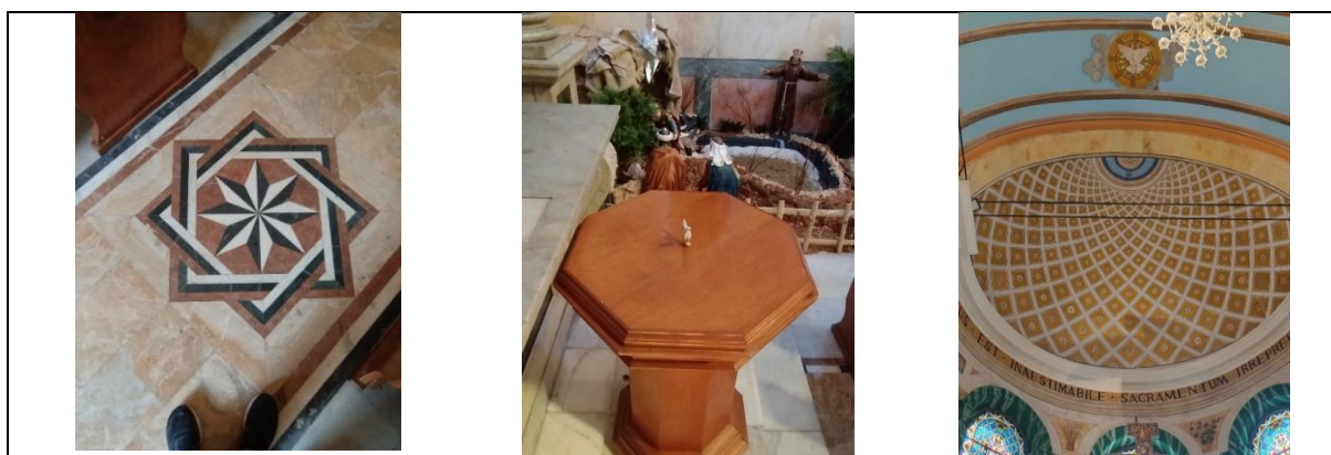
Figura 4 - Registros feitos durante a visita à Igreja de São Sebastião.
