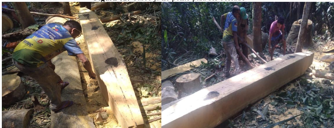
Figura 02: Casco já no ponto para ser boleado
